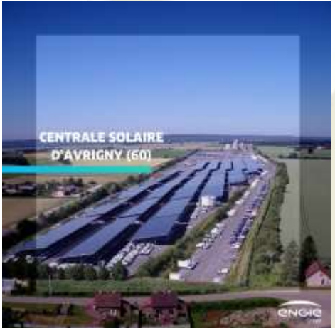
Ombrières du parking de STVA Avrigny 8,7 GWh produits (7,17MW installés)
